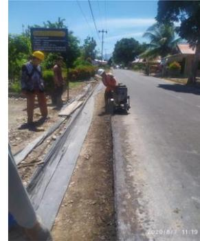
5) Selanjutnya **pasang bekisting** (disyaratkan yang kaku/dari besi) dan tutup lapisan dibawah beton dan permukaan aspal menggunakan plastik cor.
