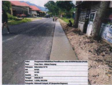
9) Perawatan dilakukan dengan menutupi permukaan beton menggunakan karung basah. Setelah minimal 12 jam pada saat pengecoran bekisting dibongkar.
