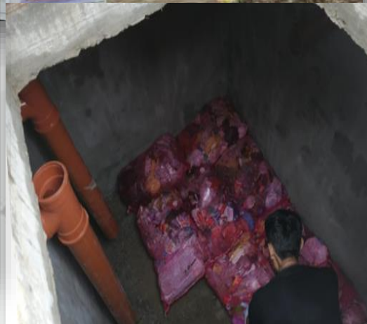
Gambar 4.46. Pembuatan anaerob filter untuk IPAL
