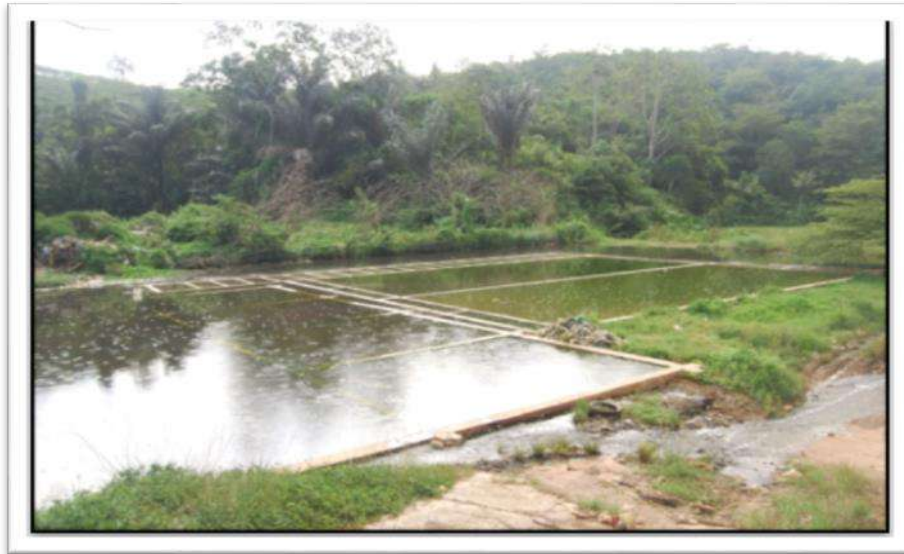
Gambar 2.7 Kondisi Kolam Lindi TPA Sampah Regional Payakumbuh
