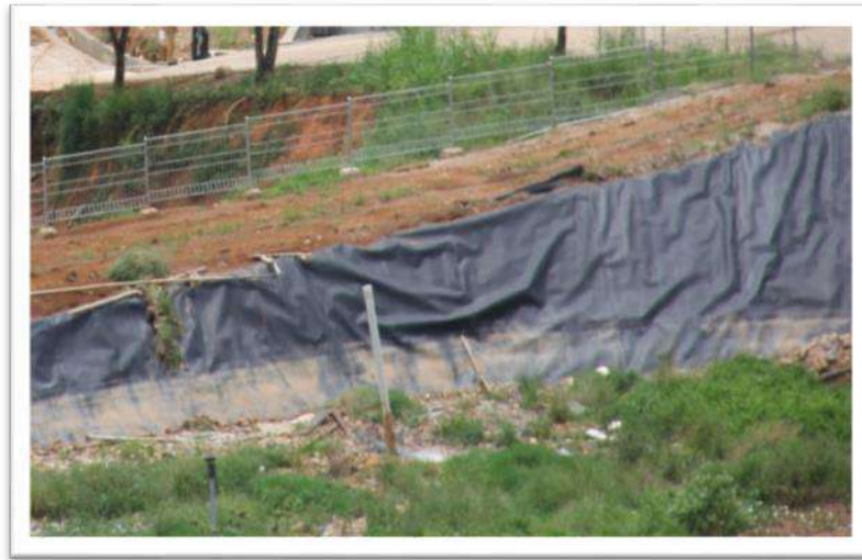
Gambar 2.6 Kondisi Lapisan Kedap Air pada TPA Sampah Regional Payakumbuh
