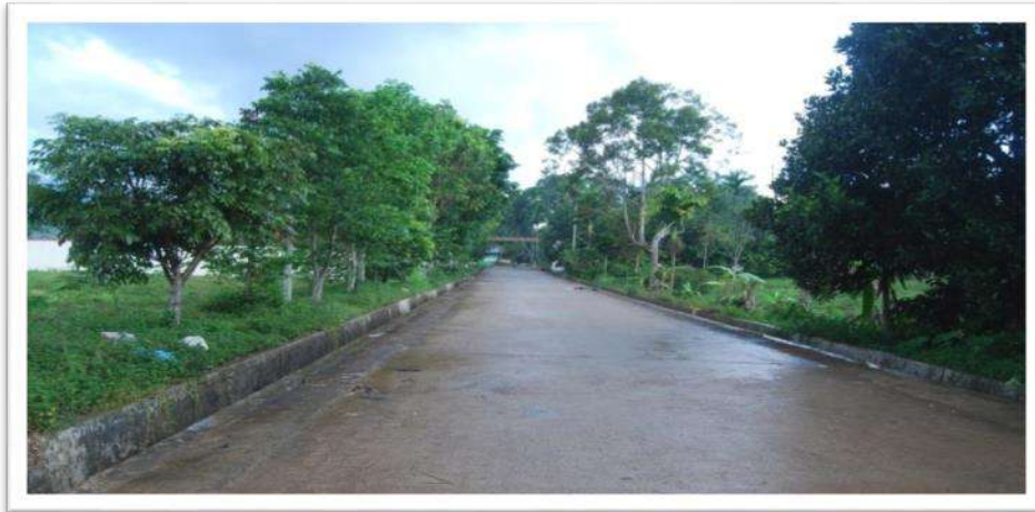
Gambar 2.4 Jalan Akses ke Lokasi TPA Sampah Regional Payakumbuh
