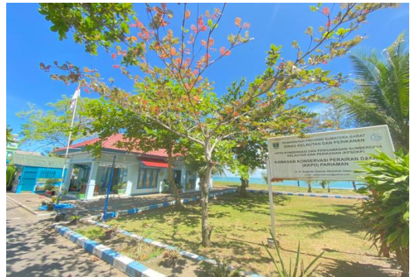
4. INSTALASI KKD KOTA PARIAMAN
